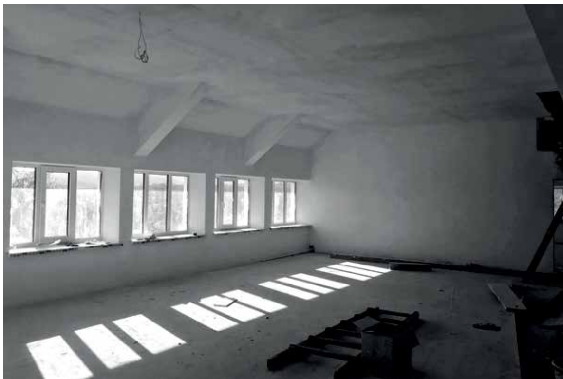
Huis van de Hoop in aanbouw, dank zij Bronkerkgangers.
